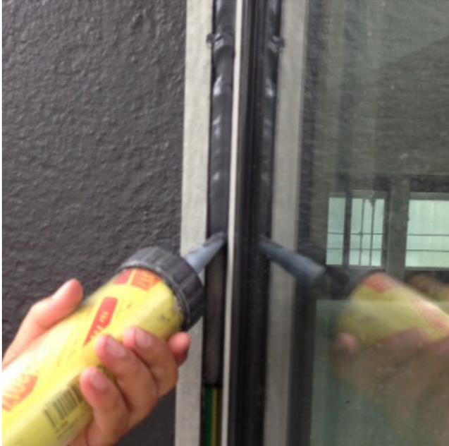
*Befüllen der vorbereiteten Fuge mit dem Dichtstoff*
