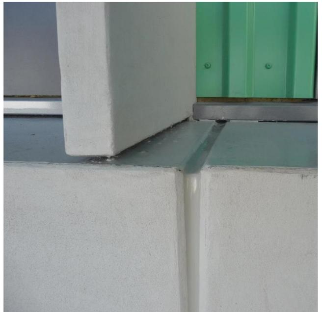
*Bild einer fertigen Fuge*
