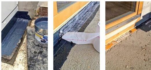
Gomastit Aqua-Protect-Flex liquid. Entwickelt für die dauerelastische Bauwerksabdichtung. Für horizontale und vertikale Flächen am Flachdach, Sockel und Anschlussbereich. Sehr breites Haftspektrum auch auf Bitumen und Teer. Geprüft nach DIN 18195 Teil 4, 5 und 6. Prüfberichte und Klassifizierungen nach DIN EN ISO 11925-2 und DIN CEN/TS 1187 sowie DIN EN 13501-1 bis -5 liegen vor. Gebindegrößen: 1,13 kg, 6 kg, 16 kg
