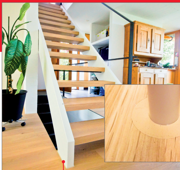
Anschlussfuge und Heizrohrdurchführung spannungsfrei abdichten (Gomastit 2060)
