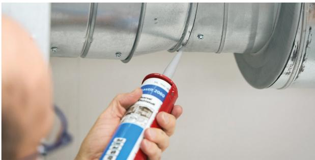
Die VDI 6022 beschäftigt sich mit der Hygiene raumluftechnischer Anlagen und Geräte. Gomastit 2060 entspricht nach Prüfung in einem externen Labor den Hygieneanforderungen der VDI 6022 Blatt 1, Ausgabe 2018.
