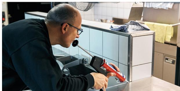
Wollen Sie in einer Bäckerei oder einer Industrieküche Fugen erstellen? Gomastit 2060 kann unbedenklich zur Verfugung im Wand- und Bodenbereich in Lebensmittelverarbeitenden Betrieben verwendet werden. Für diese Bestätigung wurde der Dichtstoff vom Institut ISEGA auf die Migration nach EN 14338 geprüft.
