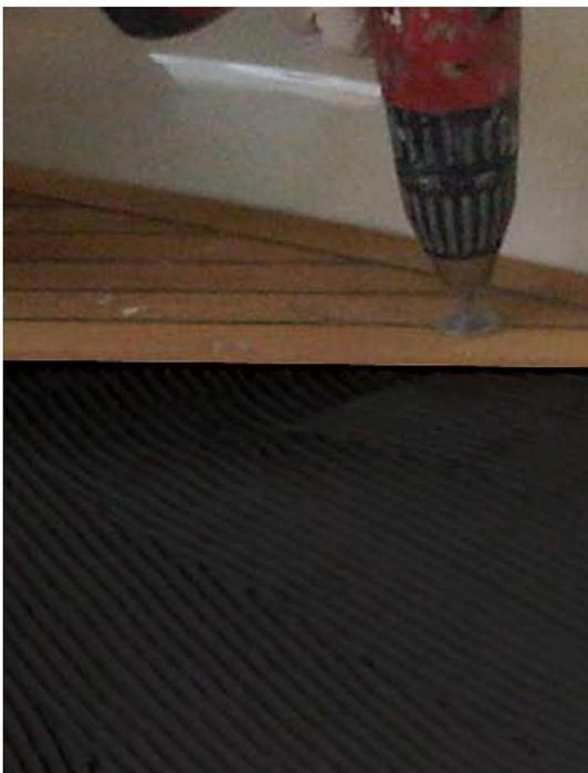
Der Auftrag von Merbenit DB50 erfolgt mittels Zahnpachtel, (geeignete Zahnung ca. 5 x 5mm).
