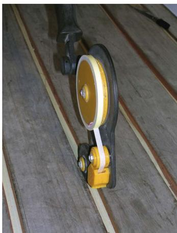
Sobald die Fugenflanken in einem einwandfreien Zustand vorliegen (Schmutz-, Staub-, Öl-, und Fettfrei), wird falls nötig bei Fugen ein Fugenband eingelegt, damit eine Dreiflankenhaftung vermieden werden kann. Auftretende Fugenbewegungen können somit optimal durch den Dichtstoff aufgefangen werden.
